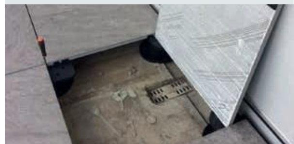
Nach dem Lösen der Arretierung ist der Untergrund zugänglich
