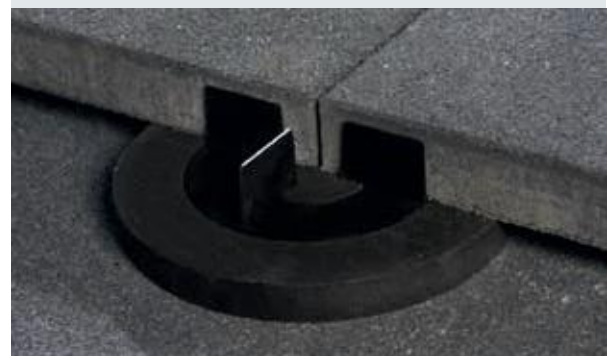
Dreen®Magna 100x100x6 wird der Dachschräge folgend auf einer Lagerplatte mit Fugenkreuz verlegt
