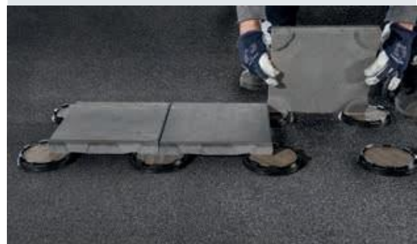
Verlegen von Dreen®Nxt der Dachschräge folgend mit der Lockplate direkt auf dem Dachbeleg
