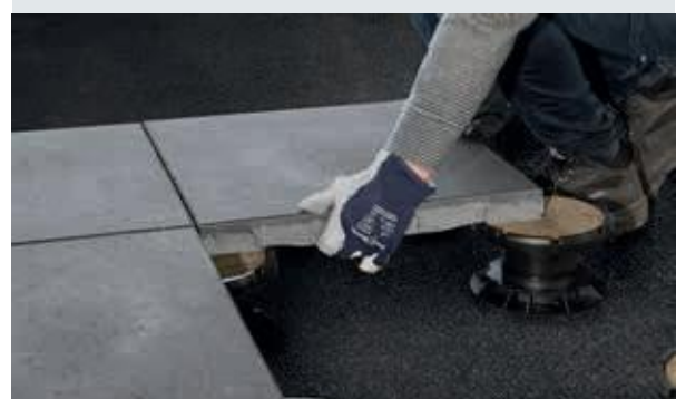
Dreen®Nxt hat Aussparungen an der Unterseite, in die die Lockplate genau passt
