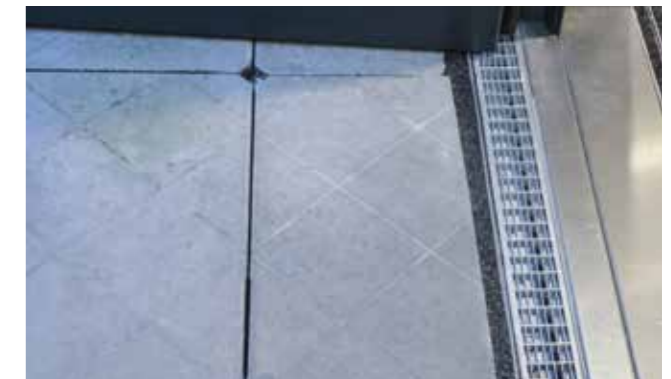
Ausführung der Entwässerungsrinne im Übergang Parkdeck-/Shoppingbereich
